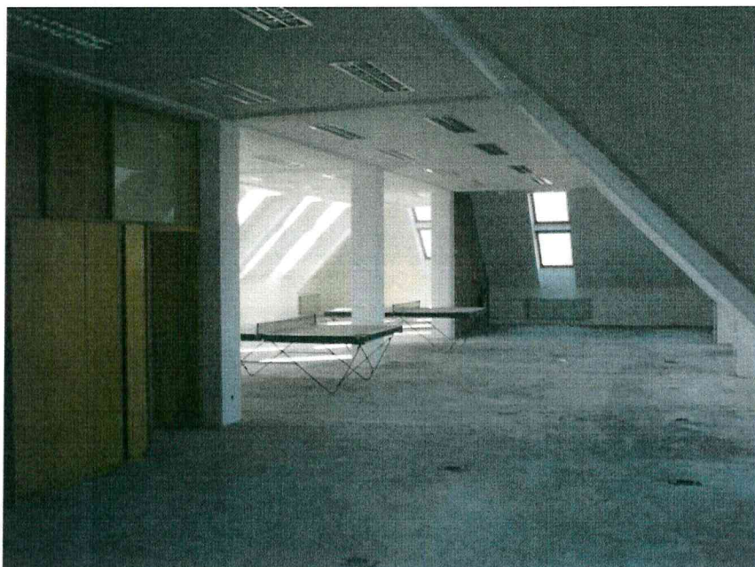
Pogled proti zahodnemu delu (pisarne 6-9 in DCV)
