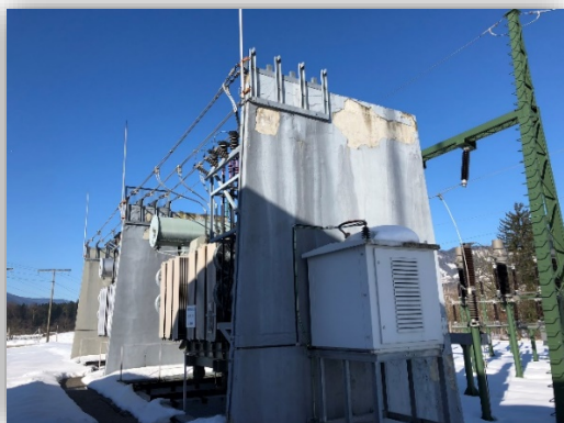
Slika 2: Požarne stene med transformatorji
