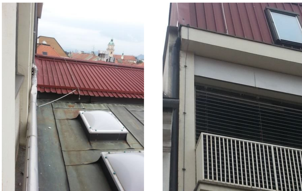
Slika 3: Obstoječa stavba, pogled na streho na zahodni in vzhodni strani objekta
