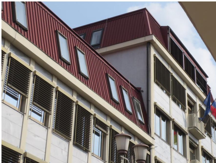
Slika 2: Obstoječa stavba, pogled na streho na zahodni strani objekta
