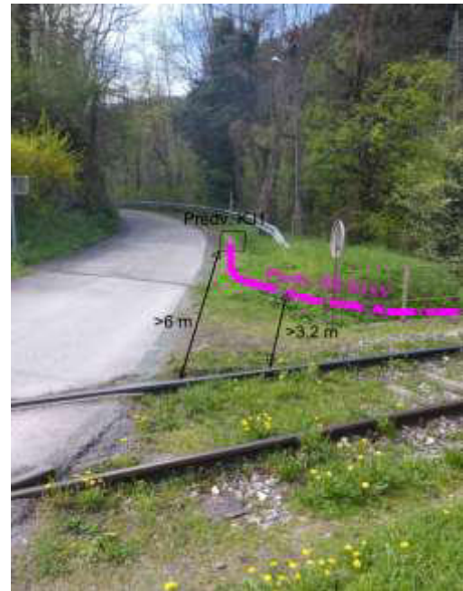
Prikaz 10: Prehod KB 20 kV iz mostne konstrukcije
